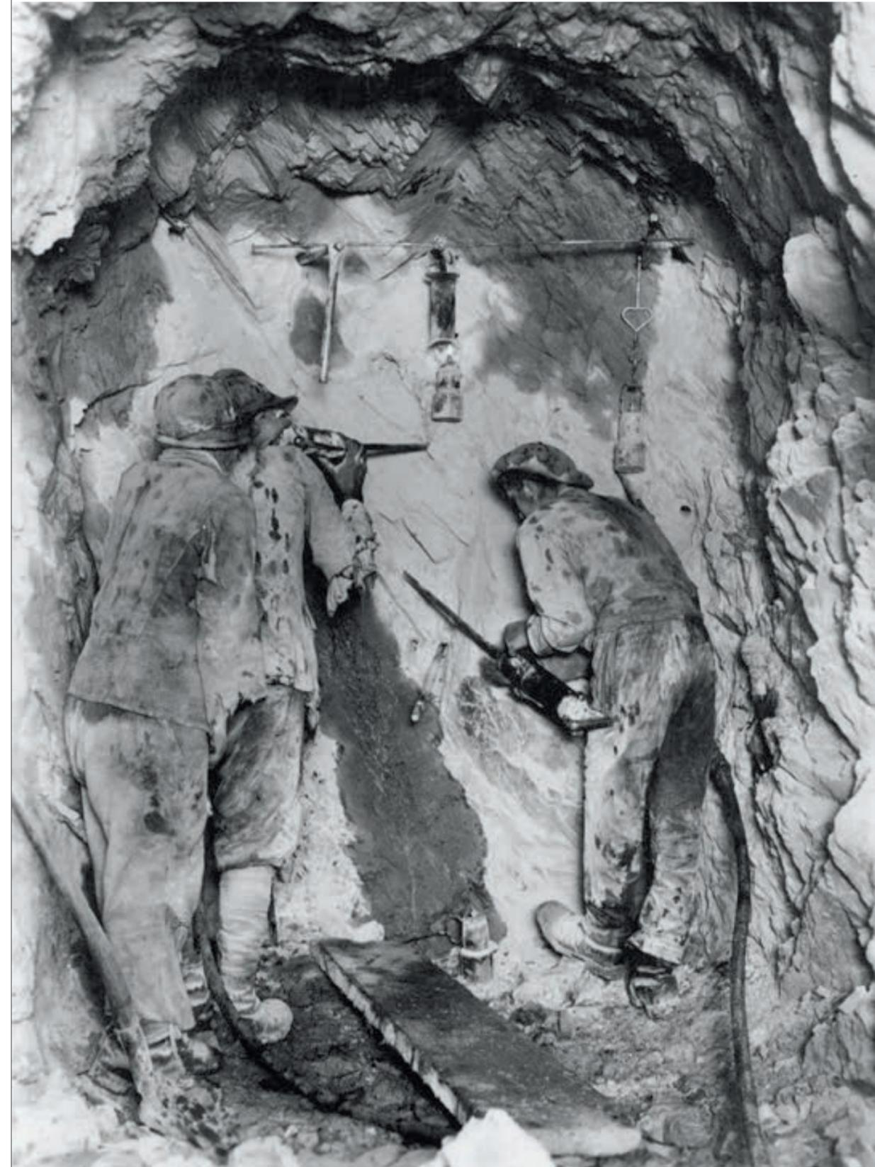
Mineure beim Abbohren des Gesteins mit Druckluftschlämmern bei Silenen im Kanton Uri, 1923. Ihre Kleidung ist voller Bohrstaub.
